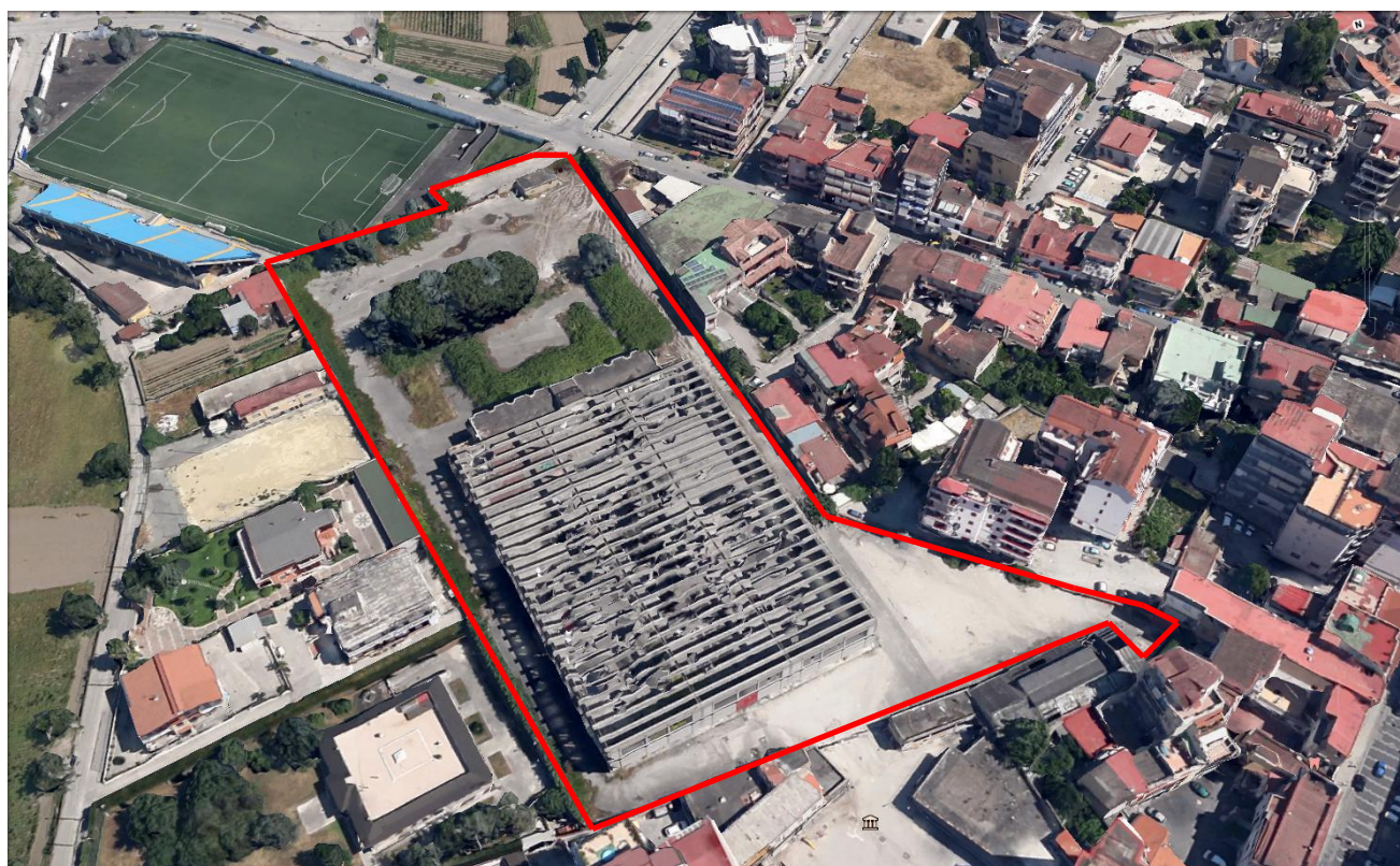
Immagine 4 – area di pertinenza dell'ex stabilimento FARVIMA
