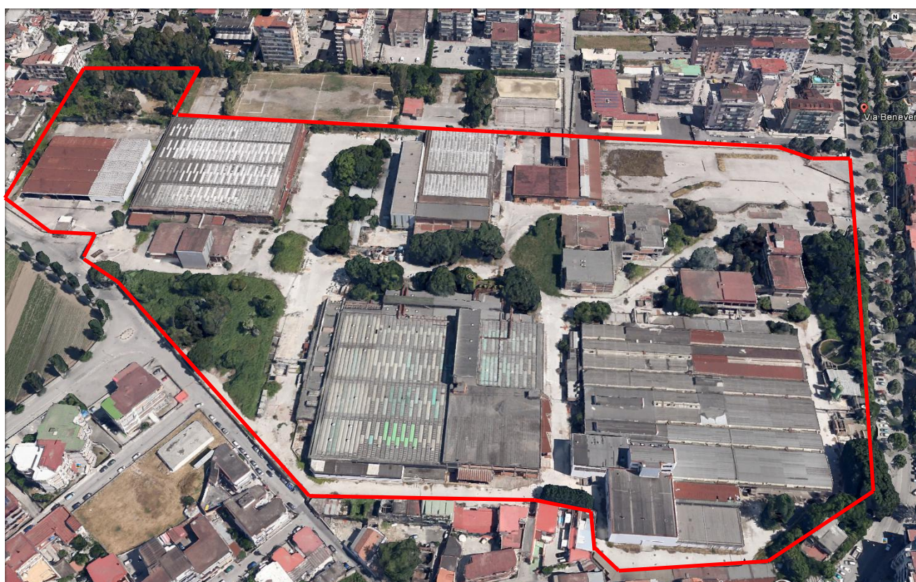
Immagine 5 – area di pertinenza dell'ex stabilimento EXIDE
