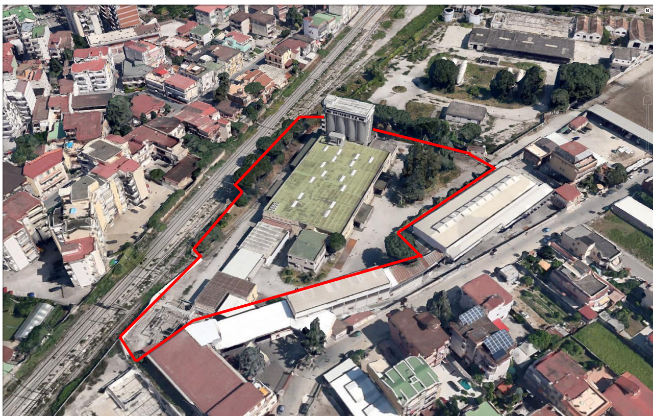
Immagine 1 – area di pertinenza dell'ex stabilimento ERIDANIA
